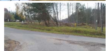
Przedszkole w Żabiej Woli także jest w trakcie budowy
